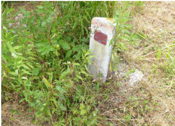
5 – borne du réseau Air Liquide
