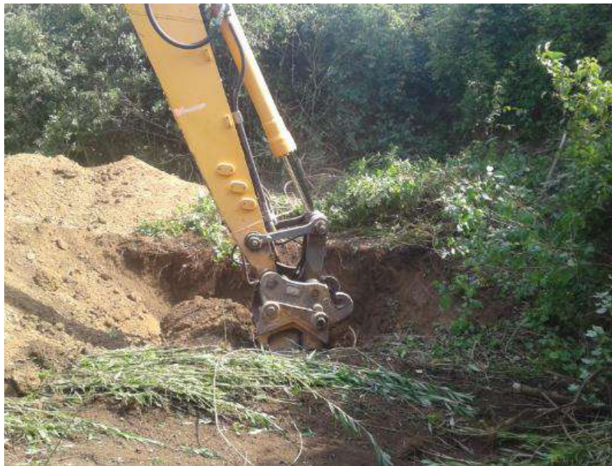
Figure 17 : illustration de la réalisation d'un sondage à la pelle hydraulique
